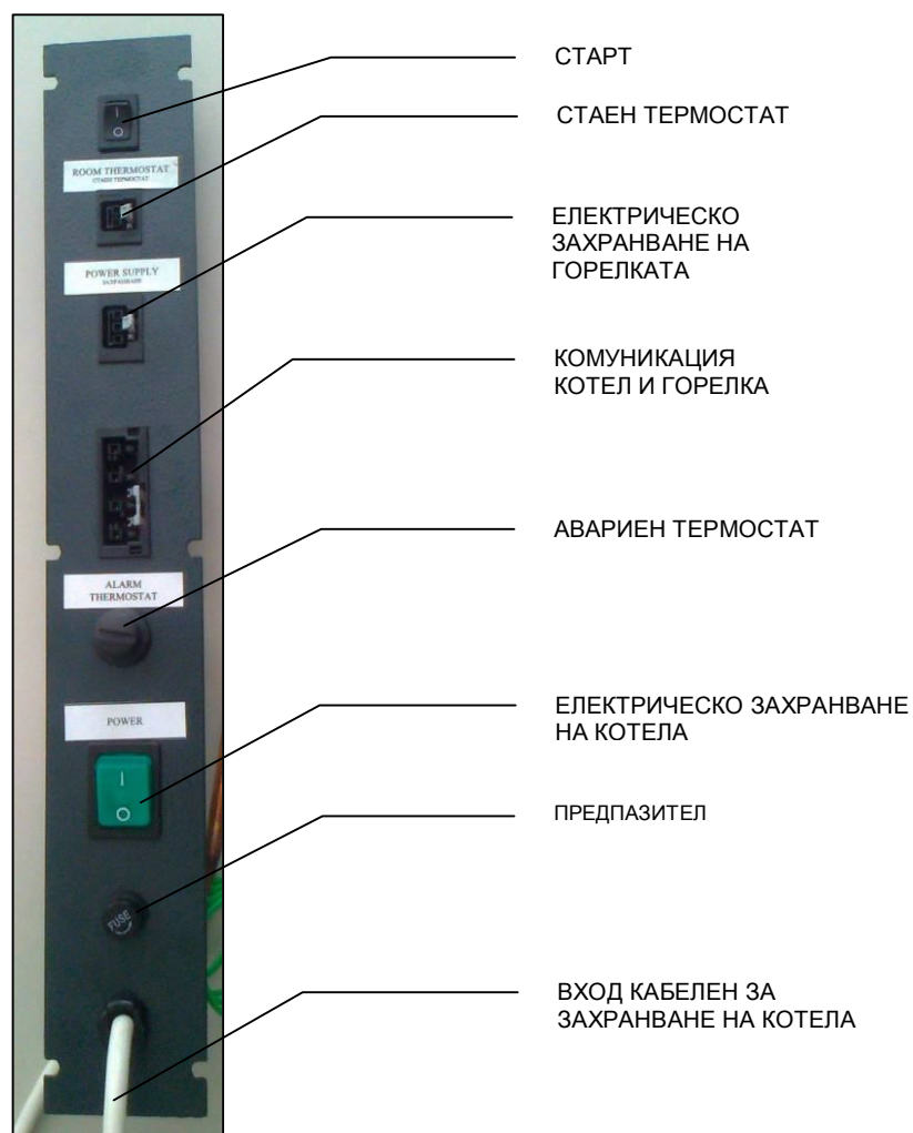
Фигура 10. Електрическо табло за управление на котела
