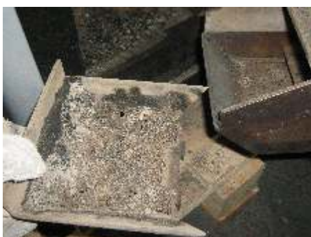
Изхвърлете пепелта от скарата на горелката в пепелника на котела или в друг подходящ съд.
