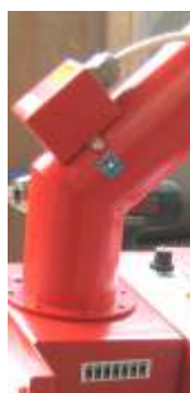
Реверсивния термостикер на горелката трябва да се проверява при всяко обслужване на съоръжението. Той показва необходимостта от почистване.
