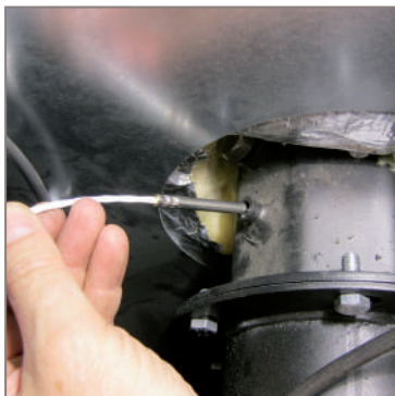
Sonda temperatura fumi. Flue gas temperature sensor. Sensor de temperatura de gases de combustión. Capteur de température des gaz de combustion. Abgastemperaturfühler.
