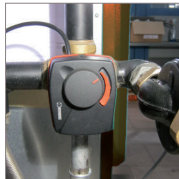
Valvola miscelatrice a 4 vie per una perfetta protezione dai flussi di ritorno. 4-way mixing valve for perfect protection from return flows. Válvula mezcladora de 4 vías para la protección perfecta de los flujos de retorno. 4 voies de mélange pour une protection parfaite contre les flux de retour. 4-Wege-Mischventil für perfekten Schutz vor Rückflüsse.
