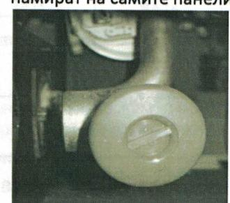
**Предпазен термостат за температура на водата с ръчно рестартиране:** ако температурата на резервоара за вода надвишава зададеното безопасно ниво от 100°C, незабавно спира работата на пелетна камината и на дисплея ще се изпише **"ALAR-SIC-FAIL"**. За да стартирате отново пелетната камина трябва да рестартирате ръчно.
