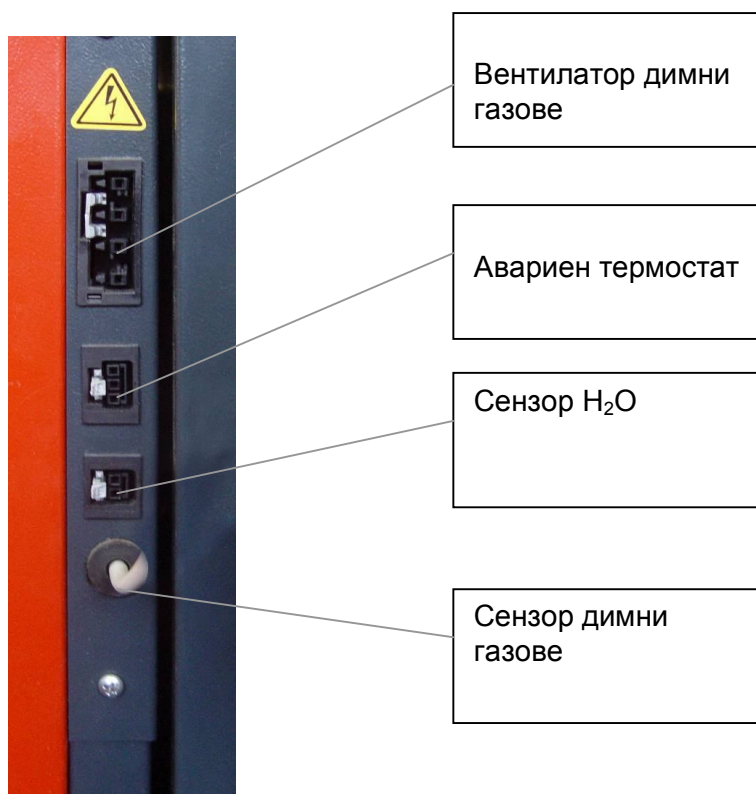
Фигура 6.4. Означение на електрическите куплунзи, монтирани на интерфейсия панел на котела.
