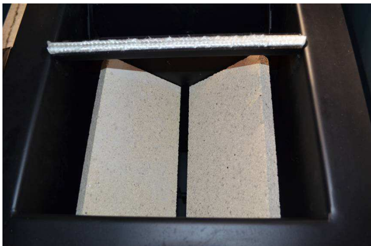
Фигура 5.3. Монтаж на шамотните елементи в пещната камера на котела.
