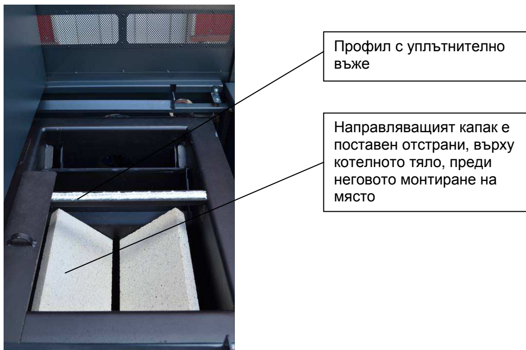
Фигура 5.5. Направляващият капак е демонтиран и се вижда изходящото сечение за димните газове на котела.
