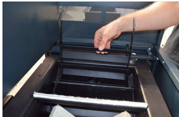
Фигура 5.7. Монтаж на турбулизаторите на двата хода на топлообменника.
