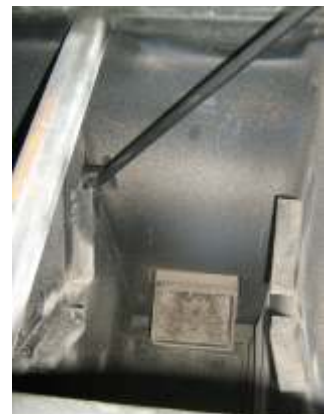
Почистете с изстъргване стените на теплообменника.
