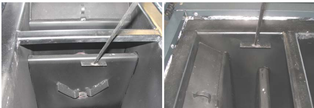
Фигура 5.5. Почистване на пепелния остатък от стените на котела.
