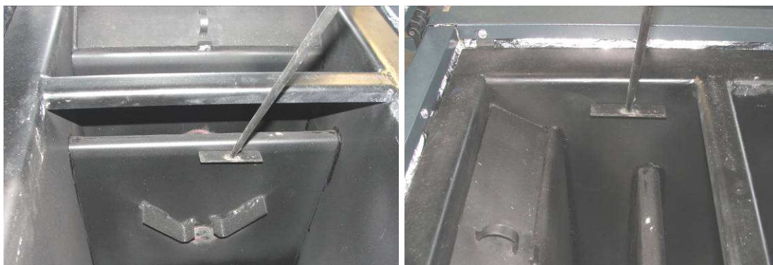
Фигура 5.3. Почистване на пепелния остатък от стените на котела;
