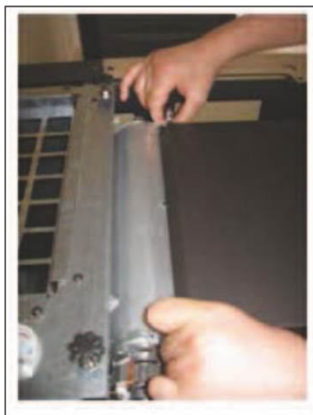
Фигура 6.6. Почистване на тръбите за отвеждане на димните газове.
